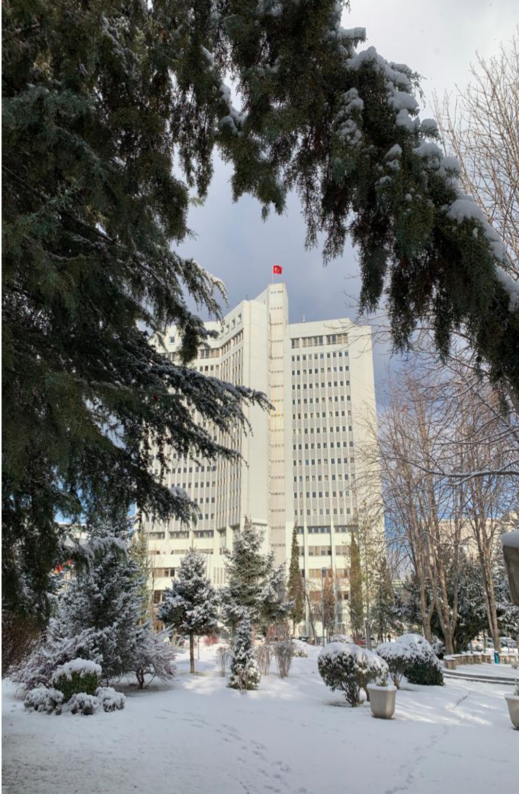
Dıőıőleri BakanlıĐı Merkez Binası
